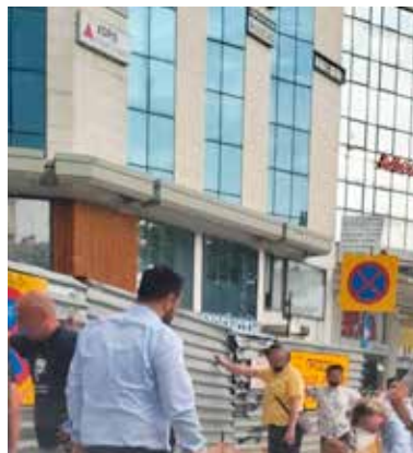
Ο Γ. Δαρδαμανέλης στο εργοτάξιο του μετρό
