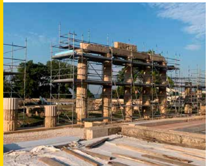
Έργα στερέωσης, αναστήλωσης και ανάδειξης του Ανακτόρου στις Αιγές
