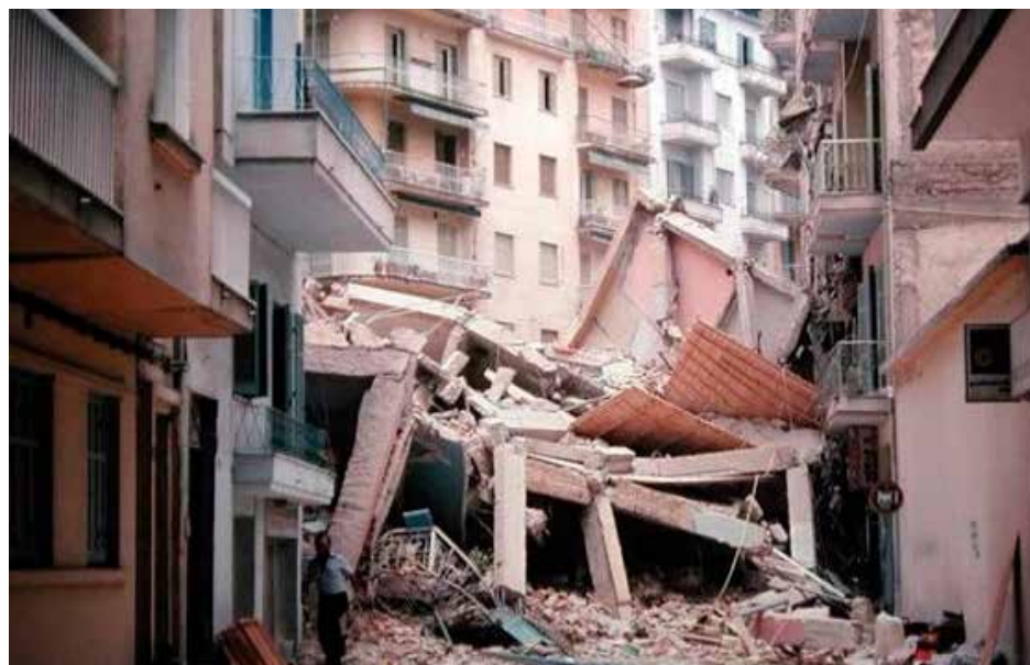
Τα ερείπια από την πολυκατοικία στην Ιπποδρομείου που κατέρρευσε στο μεγάλο σεισμό της Θεσσαλονίκης του 1978
